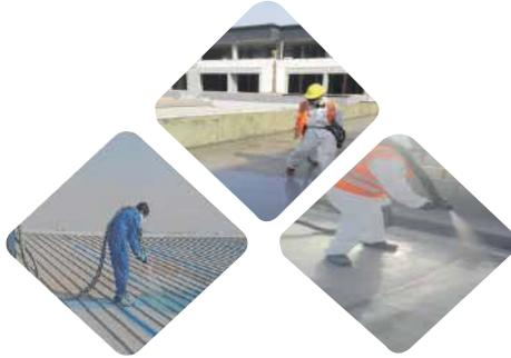
في مقاومة مياه الأمطار ومياه الصرف والاحتكاك و مقاومة معظم المواد الكيميائية، ويوجد أنواع منها معدة لعزل الأسطح المكشوفة لمقاومتها العالية لأشعة الشمس فوق البنفسجية التي لا تتحملها بعض المواد التي سبق ذكرها بالأبواب السابقة
